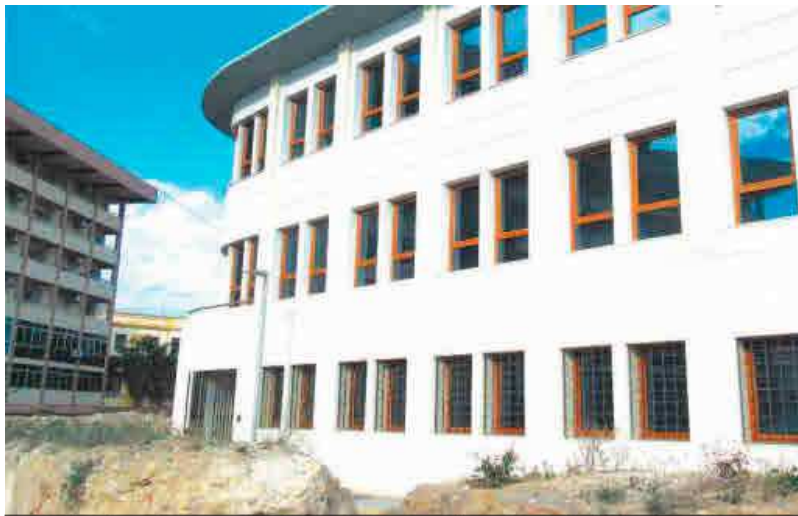
Fotografía de una de las fachadas del Centro Tecnológico.
